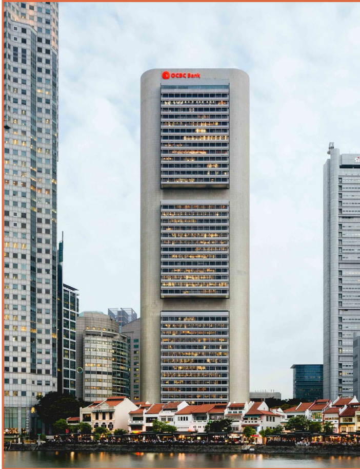
OCBC | Singapore Modernisation
